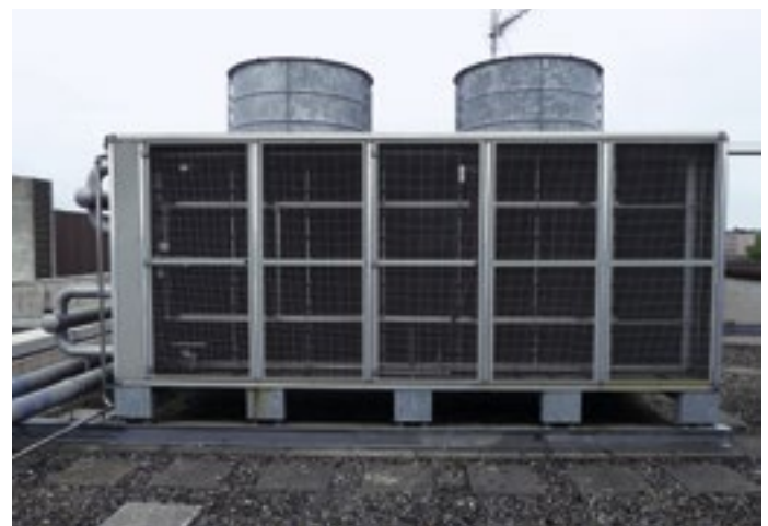
Abb. 1: Wärmepumpe zur Nutzung der Abwärme. Im Sommer wird die überschüssige Wärme hauptsächlich über Kühltürme an die Aussenluft abgegeben.
