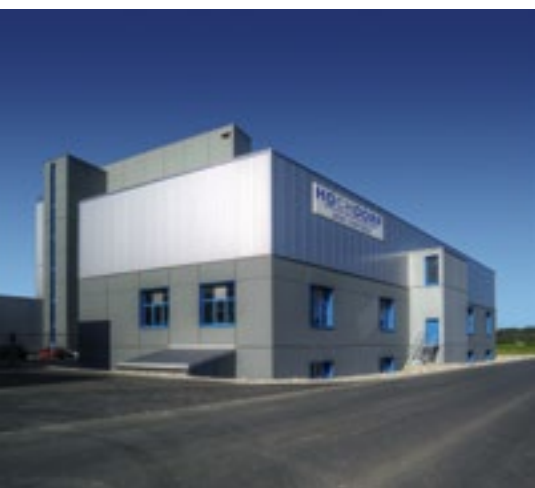
Abb. 1: Das neue Werk Sulgen TG der Firma Hochdorf Nutritec.
